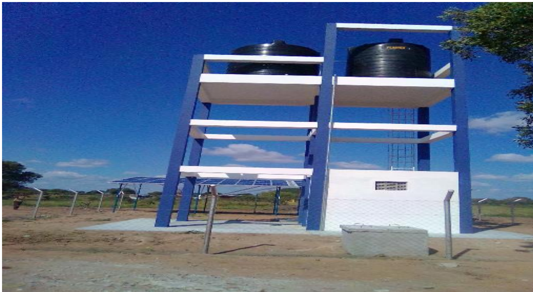
Sistema Multifuncional de Abastecimento de Água
